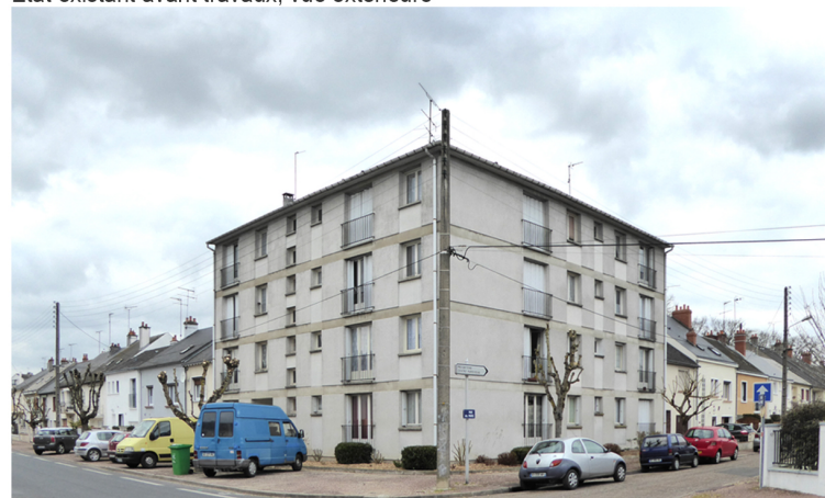
Etat existant avant travaux, vue extérieure
