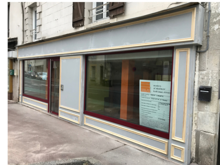
Façade avant mise en peinture
