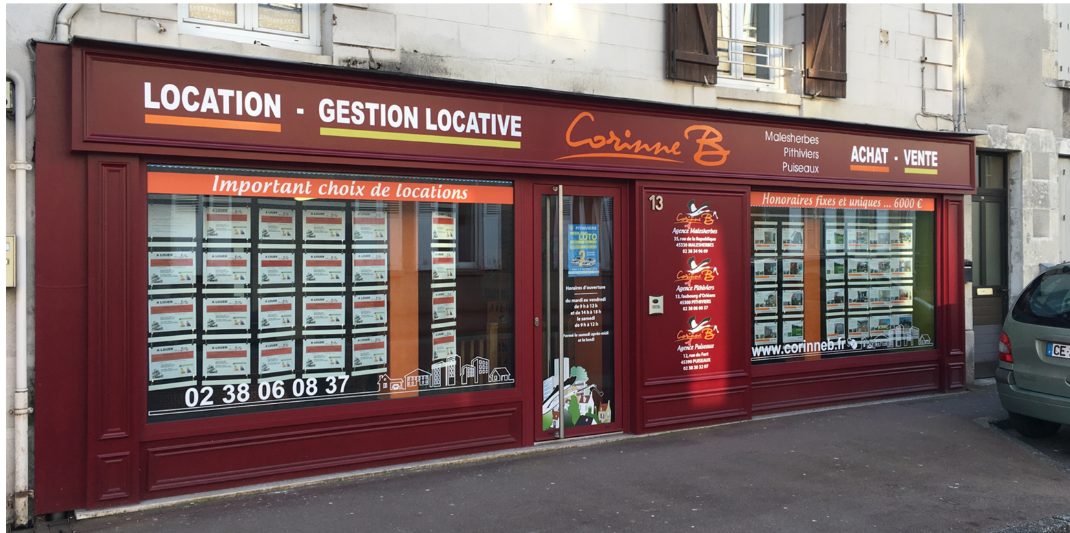
Façade après travaux
