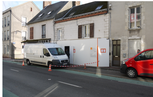
Sécurisation du site
