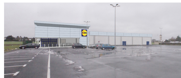
Ferrières en Gâtinais
